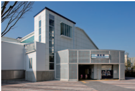
港町駅舎改修工事
