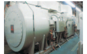
フライホイール式電車線電力蓄勢装置
