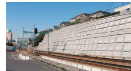
防護柵と落石検知装置を整備
