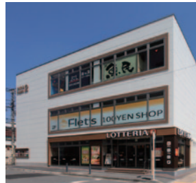
新町第2京急ビル
