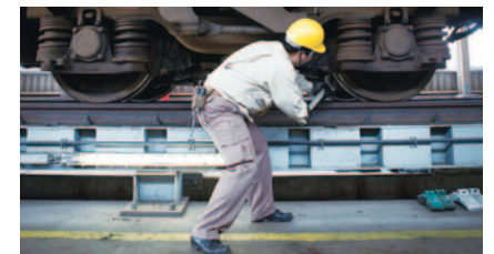
車両管理区での点検
