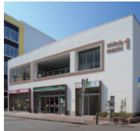
新町第1京急ビル
