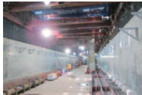
産業道路駅付近での躯体構築状況
