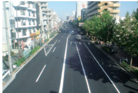
中原街道路面補修工事
