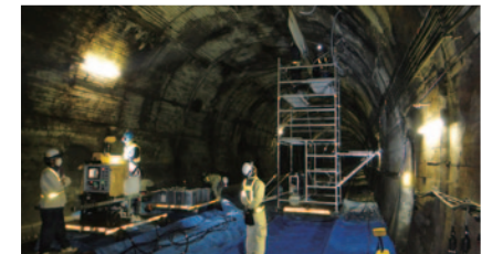
トンネルの補修工事の様子
