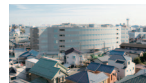
金沢文庫現業事務所 外観
